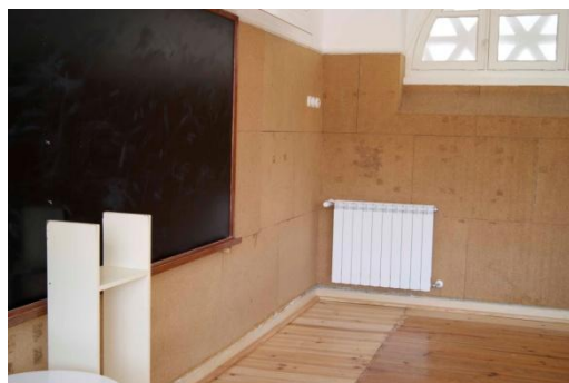
Imagem 4 – Interior de uma das salas da Escola Básica de Montargil nº2
