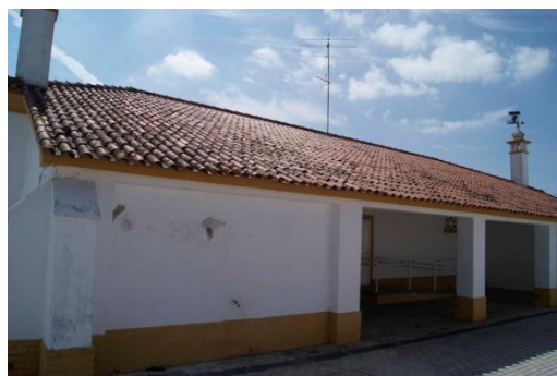
Imagem 2 – Telhado da Escola Básica de Montargil nº2
