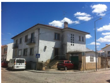
Imagem 1 – Exterior da Casa dos Magistrados
