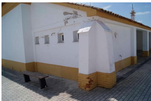
Imagem 3 – Fachada da Escola Básica de Montargil nº2
