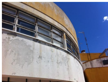
Imagem 2 – Fachada do Centro de Convívio
