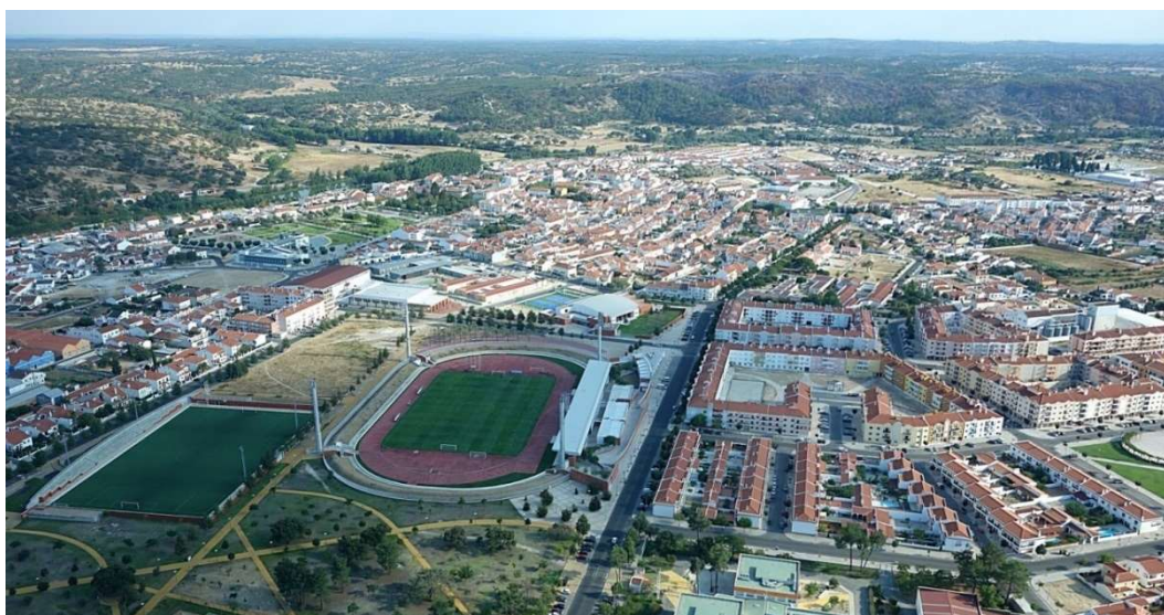
Figura 11. Vista aérea da zona de expansão noroeste de Ponte de Sor
