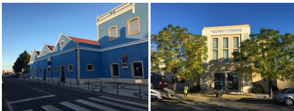
Figura 31. Centro de Artes e Cultura (esquerda) e Cinema de Ponte de Sor (direita) Fonte: SPI, 2016
