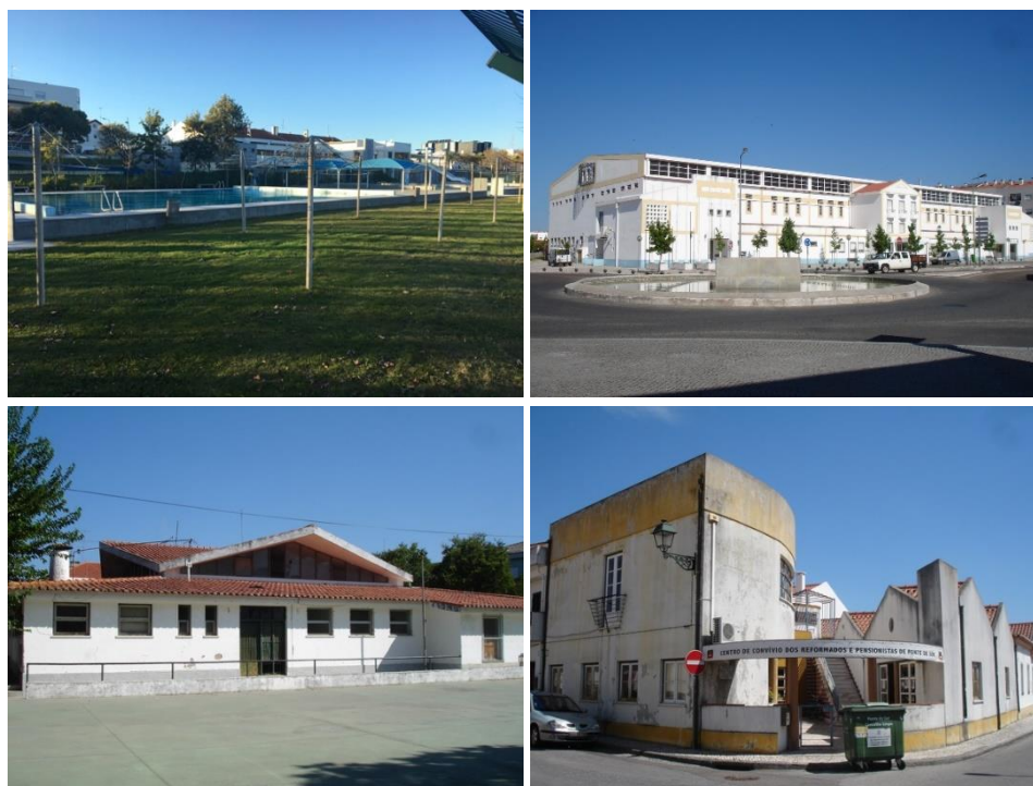
Figura 33. Piscina Municipal e Pavilhão Municipal (Gimnodesportivo I) (cima) e Casa do Povo e Centro de Convívio dos Reformados e Pensionistas (baixo)
