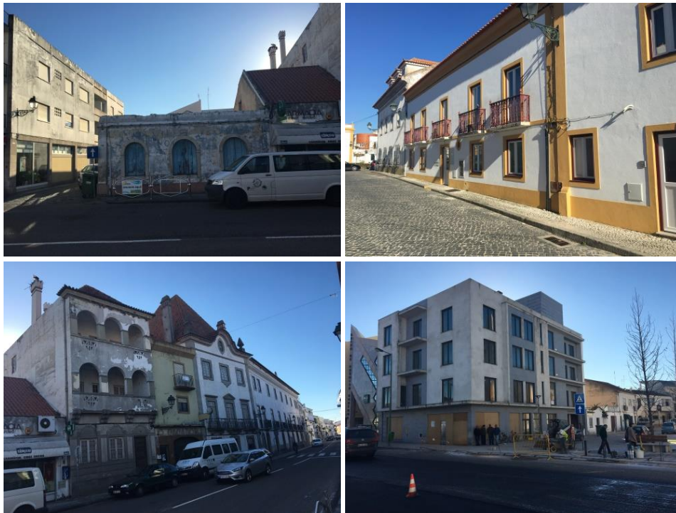
Figura 23. Exemplos de diferentes estados de conservação do edificado da ARU de Ponte de Sor Fonte: SPI, 2016
