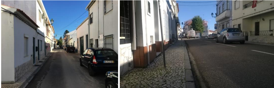
Figura 50. Vias com passeios subdimensionados na ARU de Ponte de Sor Fonte: SPI, 2016
